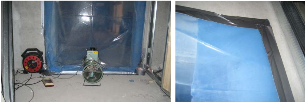
Fläkt och manometer monterade i dörr mot trapphus, tätning kring dörr.
