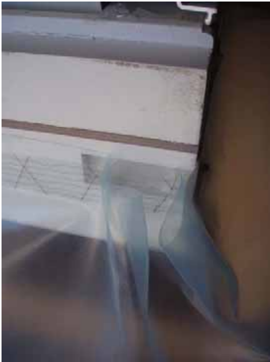
Figur 35 Vikning av plastfolie kring fönsterhörn.
