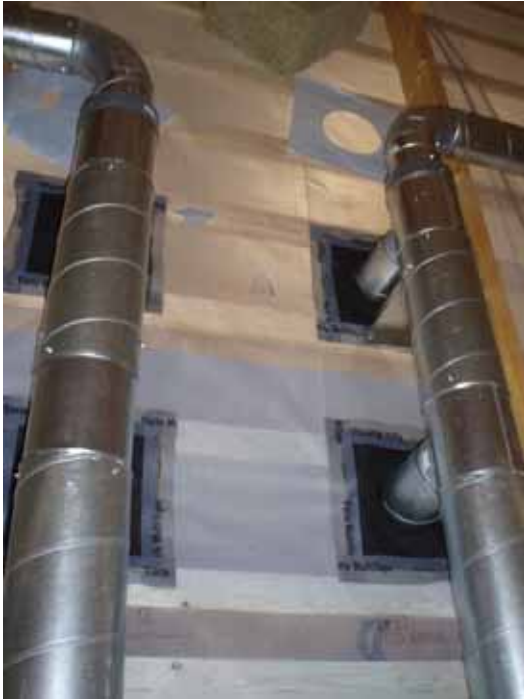
Figur 51. Planera genomföringarna: om det inte går att eliminera dem så gör dem bra.
