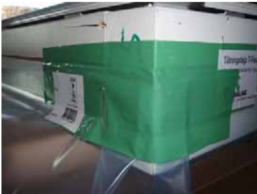
Figur 36 Tejpning på det vikta plastfoliehörnet.
