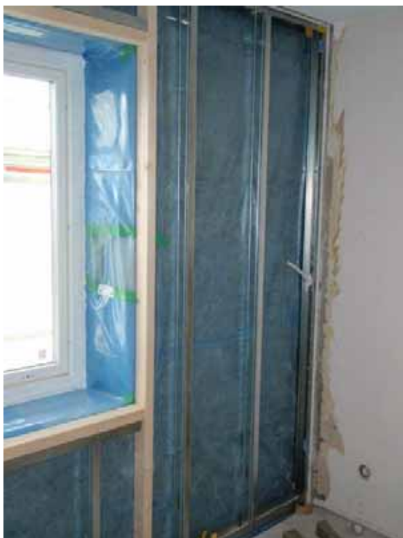
Figur 19 Exempel från renovering: indragen plastfolie och omsorgsfull anslutning av tätskikt mot fönster med tejping och fogning kring fönstret.
