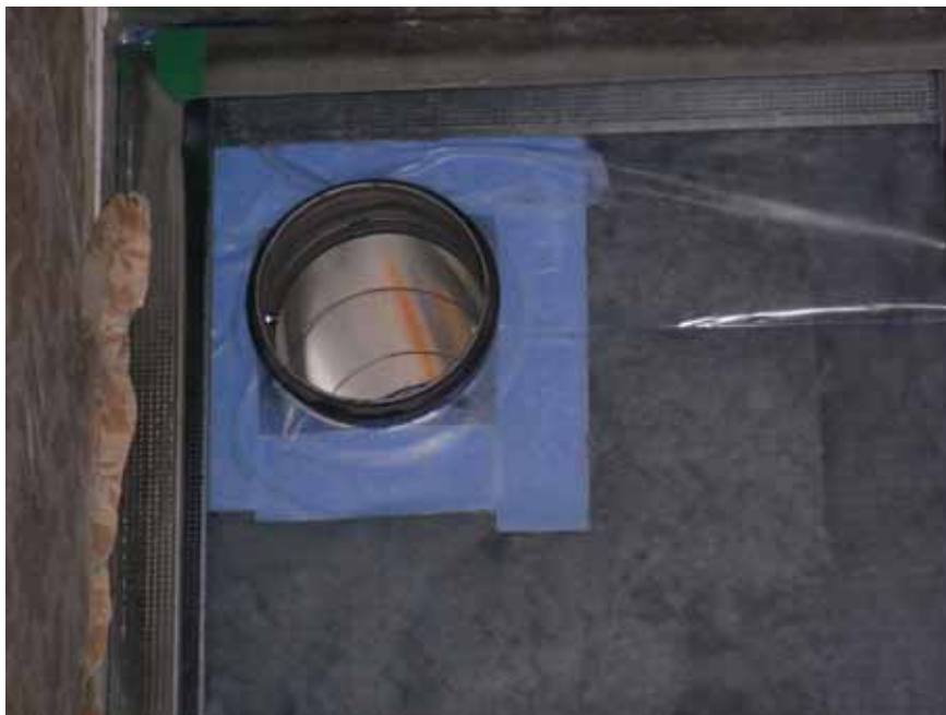
Figur 45 Ventilationskanal med extra plastfolie och tejping mot tätskikt och mot rör.
