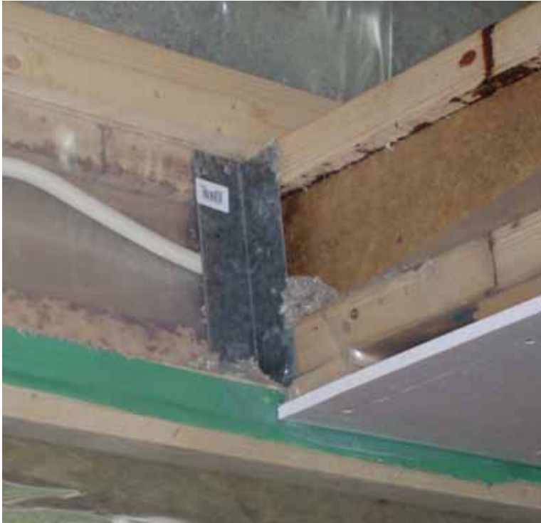
Figur 33. Infästning av mellanbjälklag mot yttervägg med balksko. Väggens plastfolie är heldragen förbi bjälklaget.
