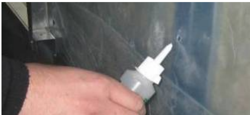
Figur 10 Spridning av rök från rökflaska vid undertryck i byggnaden.
