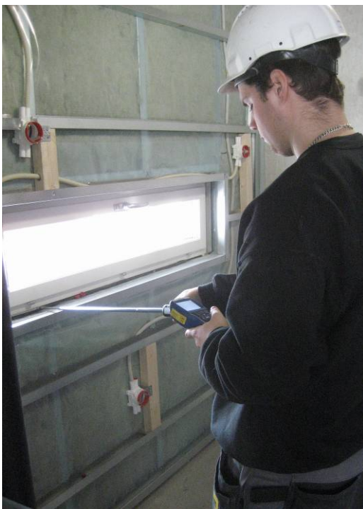
Figur 9 Läckagesökning med lufthastighetsmätare.
