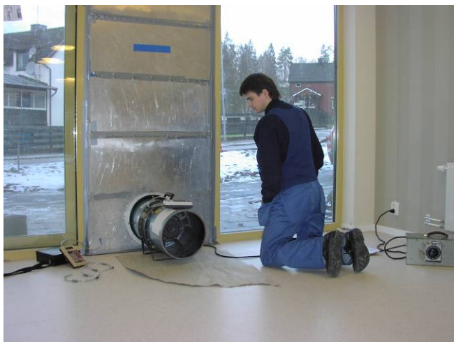
Figur 16 Fläkten placeras i en skiva i ytterdörren vid täthetsprovning.
