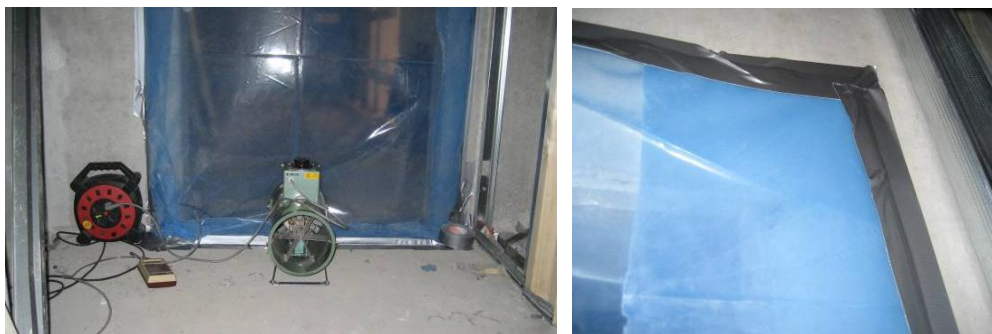
Figur 8 Fläkt och manometer monterade i dörr mot trapphus, tätning kring dörr.
