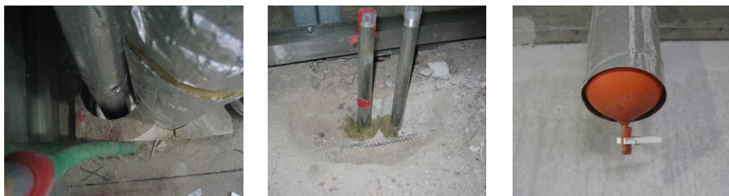
Figur 7 Hål kring genomföring i bjälklag, tätning med mineralull kring rör samt ventilationsrör tätat med ballong.
