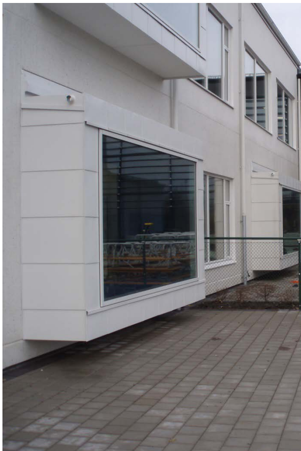
Figur 6.6 och 6.7. Tydligt exempel på fönster som kragnar ut utanför ordinarie konstruktion (i detta fall i praktiken ett burspråk). Utkragningen kan dock vara betydligt mindre och även gälla betydligt mindre fönsterpartier.
