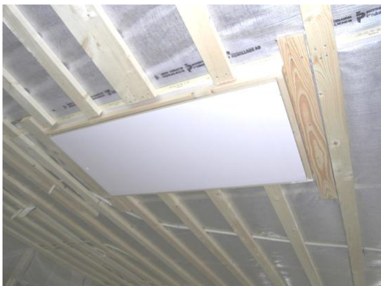
Figur 28 Vindslucka monterad i vindsbjälklag (Platsbesök)
