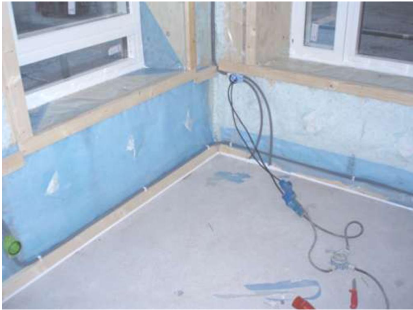
Figur 64 Hål för sprutning av lösull (Wahlgren, 2010)
