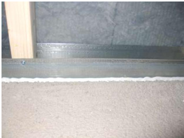
Figur 15 Plåregel med plastfolie fogad mot betong (Wahlgren, 2010).
