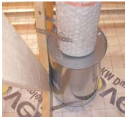
Figur 54 Genomföring av utvändigt isolerad ventilationskanal med hjälp av ljuddämpare eller dylikt (Wahlgren, 2010).
