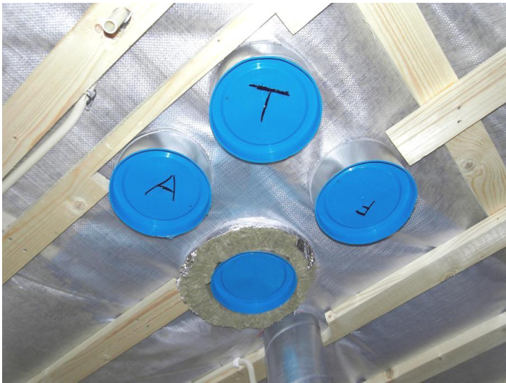
Figur 2 Ventsilningsrör genom plastfolie i vindsbjälklag
