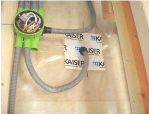
Figur 49 Genomföring av elrör med hjälp av manschett (Wahlgren, 2010).
