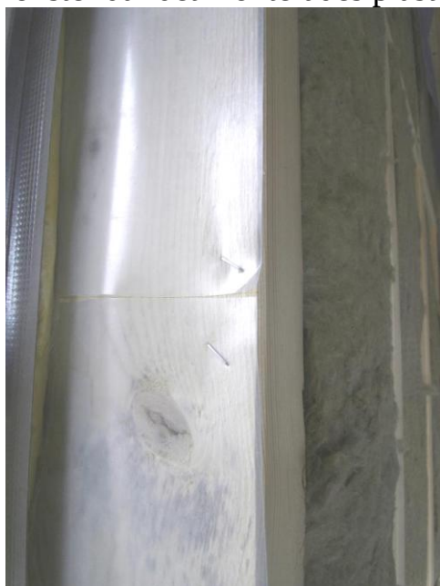
Figur 1 Ej överlappad skarv av plastfolie i fönstersmyg
