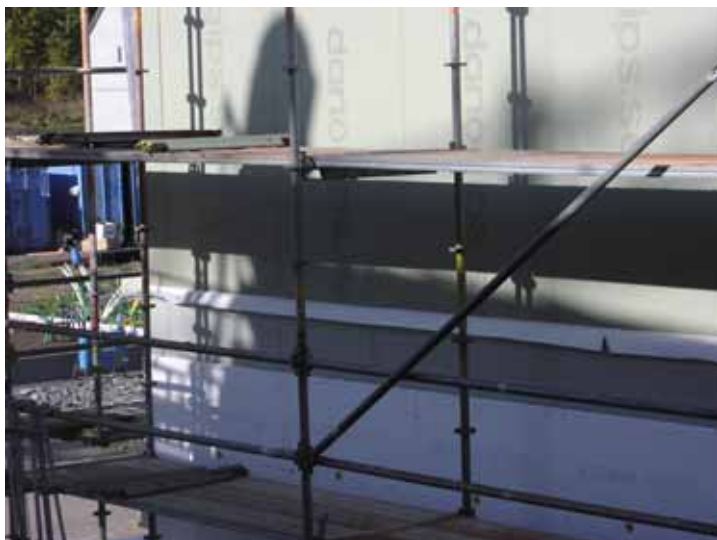
Bild 9 Utvändigt vindskydd med horisontell skarv kompletterad med vindskyddspapp.
