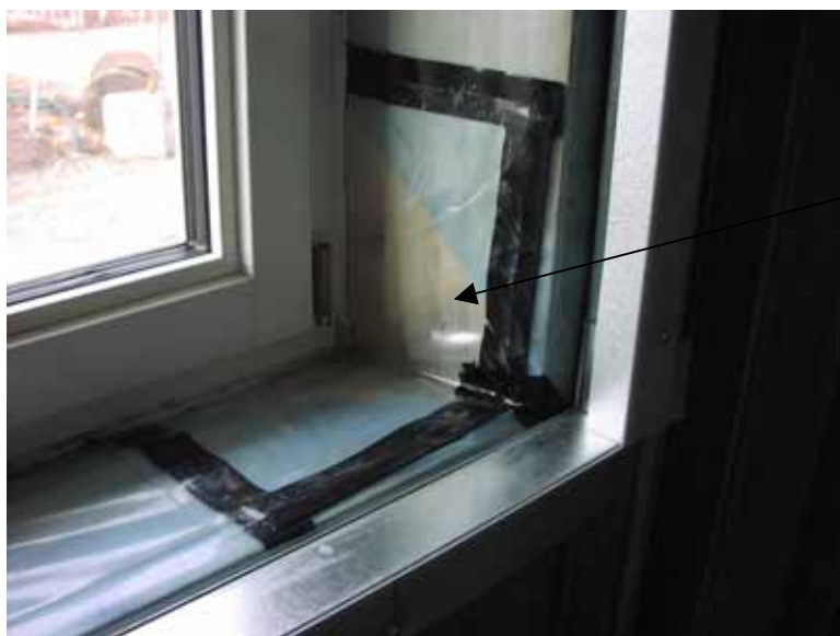
Figur 3.8 Anslutning av plastfolie mot fönster genom invik av plastfolie, tätning med extraremsor i innerhörn, tätning med butylgummiband och fogmassa runt fönsterkarm.
