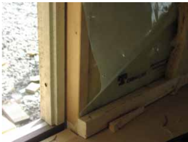
Figur 3.13 En bubbla har bildats vid monteringen av plastfolien. En sådan bubbla skapar sämre förutsättningar för lufttätethet.
