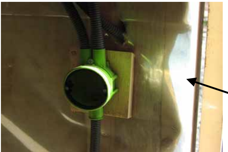
Bild 15 PE-folien bubblar vid anslutning mot dörr.
