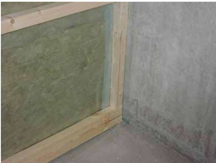
Bild 4 Anslutning av utfackningsvägg mot betongstomme. S-list finns klämd mellan syll och väggregel och betong. PE-folien är klämd med träregel mot plåtr regel.
