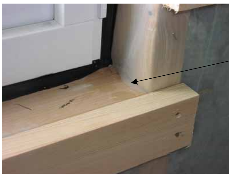
Figur 3.7 Anslutning av plastfolie mot fönster genom invik av plastfolien och fogning mot karm. Lösningen har provats på laboratorium.
