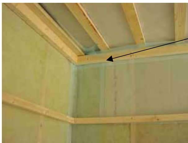
Figur 3.12 I ett innerhörn där två väggytor och en takyta möts kan det bli flera lager plastfolie som skall sluta tätt mot varandra samtidigt som plastfolierna veckas. Detta kan vara svårt att få bra arbetsutförande på.
