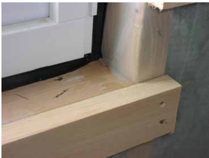
Bild 10 Anslutning vid fönster där PE-folien dragits in i smyg och ansluts med fogmassa mot fönsterkarm.
