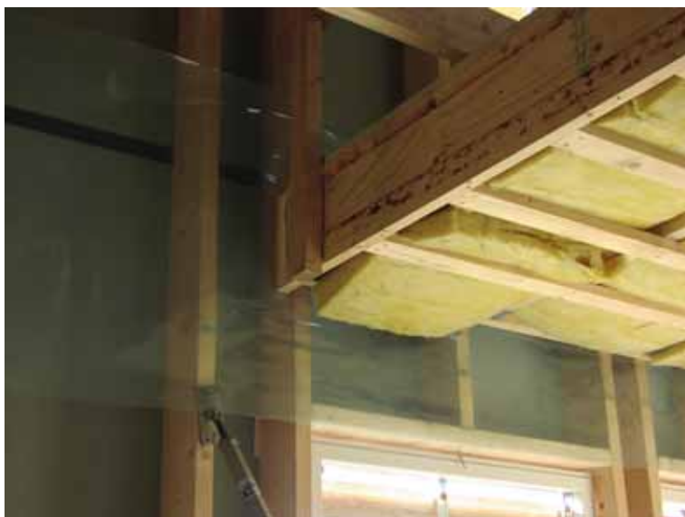
Bild 7 Prefabricerade bjälklagselement har förberetts med en PE-folie som skall anslutas mot PE-folie i vägg. På detta sätt blir PE-folien dragen hel förbi bjälklagsanslutningen som annars är en svårlöst detalj.
